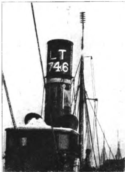
Een merkwaardige antenne aan boord van een trawler. Zij bestaat uit rechthoekige platen en werd geleverd door de firma Flinden Ltd. te Colchester (Eng.).
